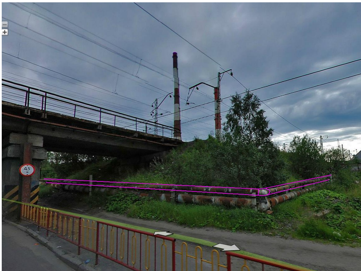
Рисунок 7. 20 Подключение к паровым сетям котельной ОАО «ММРП» Состав группы проектов № 5 «Строительство или реконструкция тепловых сетей для повышения эффективности функционирования системы теплоснабжения, в том числе за счёт перевода котельных в пиковый режим работы или ликвидации котельных» приведён в таблице 7.14:
